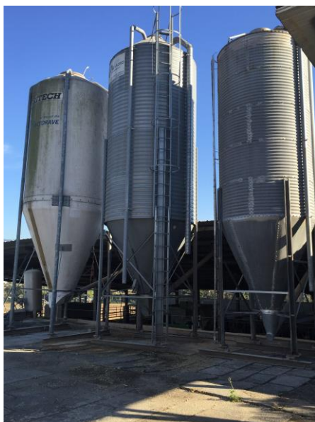
Figura 4.13 – Áreas de apoio à produção – zona de implantação dos silos de ração
