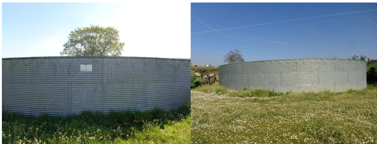
Figuras 4.2 e 4.3– Tanque de armazenamento de água para rega existente junto ao limite nascente da propriedade
